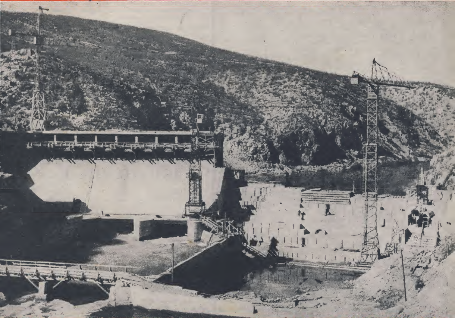
BETONSKA BRANA »PRANCEVIĆI« HIDROELEKTRANE »SPLIT«
